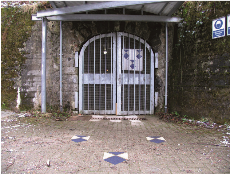
Abb. 1: Eingang zum Barbarastollen.
